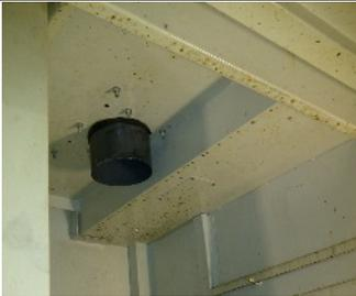
Schrauben Sie die Befestigungsmutter der Anti-Vibrationsfüße ein um den CLEAN AIR sicher festzulegen. In Abbildung ein Beispiel von vertikaler Installation des CLEAN AIRs.
