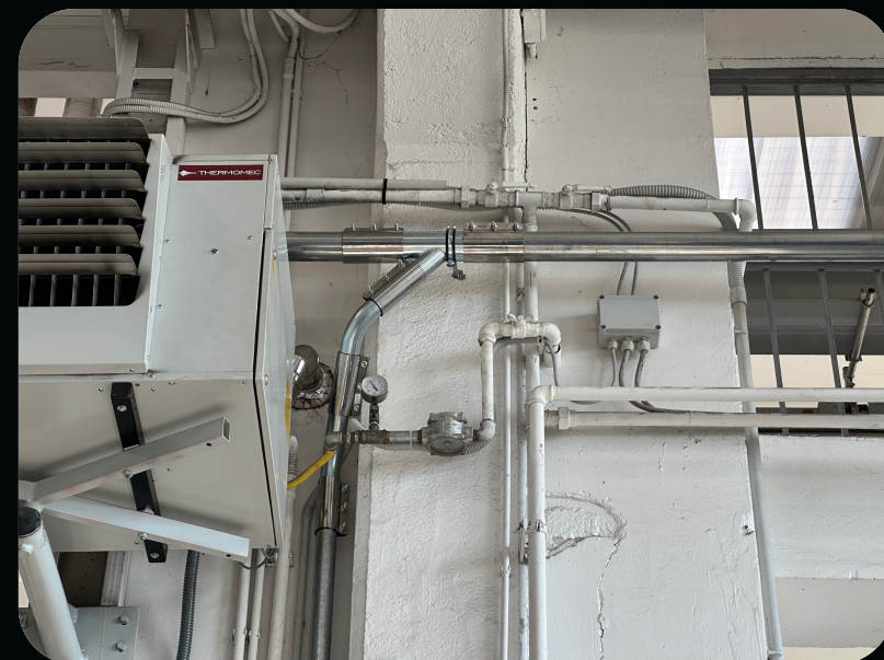
Más de 300 metros de tuberías
