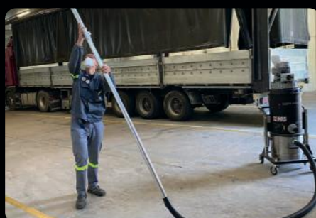
Limpieza en altura
