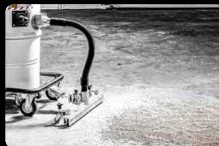
Pulizia dei pavimenti
