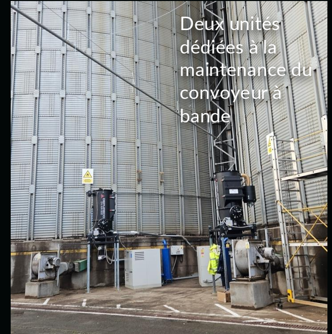
Installation de la tuyauterie et des points d'aspiration du convoyeur à bande
