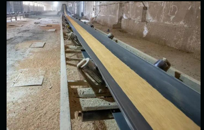
Dettaglio del tunnel del nastro trasportatore
